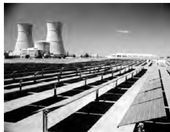
Impianto fotovoltaico da 2 MW installato presso una centrale nucleare defunta in prossimità di Sacramento in California.
