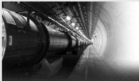
I magneti del LHC (large hadron collider) del CERN sono raffreddati a elio liquido, per mantenere le condizioni di superconduzione. 100 tonnellate di elio liquido vengono distribuite lungo i 27 chilometri dell'anello: è il più grande impianto criogenico a elio liquido al mondo.
