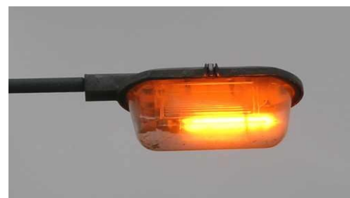
Lampada stradale antinebbia ai vapori di sodio. La caratteristica luce gialla corri-
